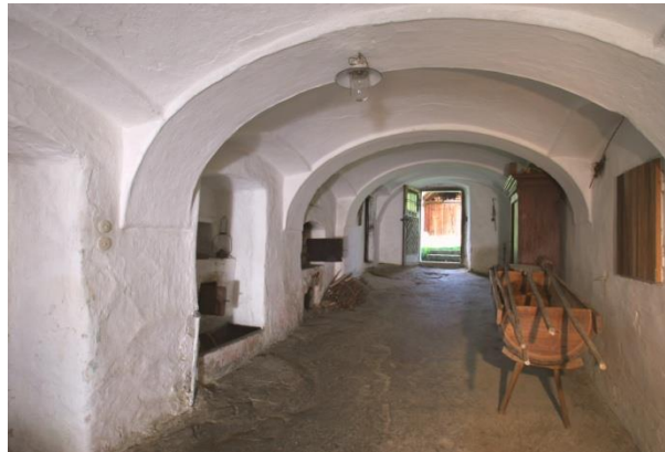
Durchhaus mit gestampftem Lehm Boden und Gurtbogengewölbe
